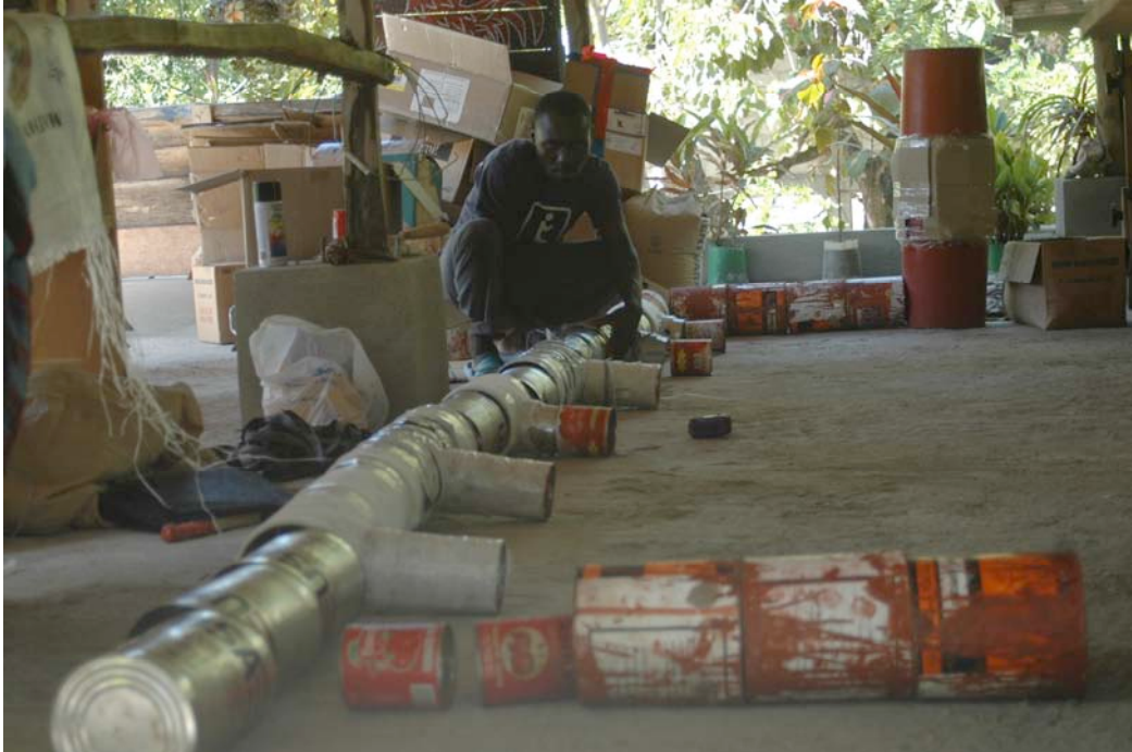
7- Système de conduit d'air chaud avec stabilisateur réalisation en cour. (Atelier Le Mabouya)
